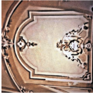
Foto 1 e 2 = distacchi di stucchi e gessi con doratura (che sono opera inizio novecentesca di G. Battista Rudelli), posti a cornice decorativa antistante un finestrone della chiesa (lato destro, primo altare).
