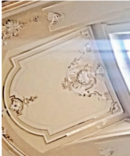
Foto 1 e 2 = distacchi di stucchi e gessi con doratura (che sono opera inizio novecentesca di G. Battista Rudelli), posti a cornice decorativa antistante un finestrone della chiesa (lato destro, primo altare).
