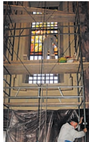
Vetrata destra in corso di posa.
