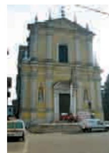
Febbraio 2011: sono in corso i lavori sulla facciata, per illuminarla.
