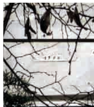
"1984": campanile, ricordo dei restauri.
